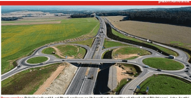
Zprovozněno Dálniční přívaděč od Plzně směrem na jih končí od včerejška až těsně před Přeštici. Jeho šestikilometrové prodloužení stálo 1,25 miliardy korun. Přívaděč je zároveň obchvatem Horní Lukavice. Foto: ŘSD
